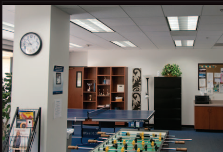
天井取付型人感センサーが人を検知します。
